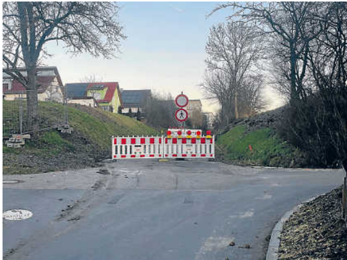
Bis zum Sommer wird eine neue Brücke über den Betonweg gebaut. Solange ist der Abschnitt leider gesperrt
